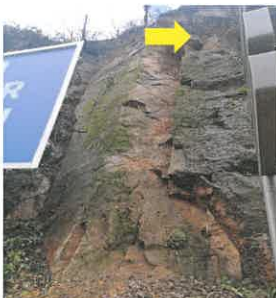
Fotografia 3 – Idem, com pormenor de bloco rochoso suspenso no topo da cicatriz de escorregamento, suportado por outro bloco rochoso
