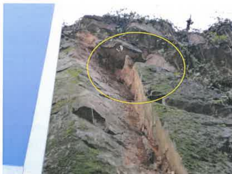
Fotografia 9 – Bloco rochoso solto em condições de equilíbrio instável.
