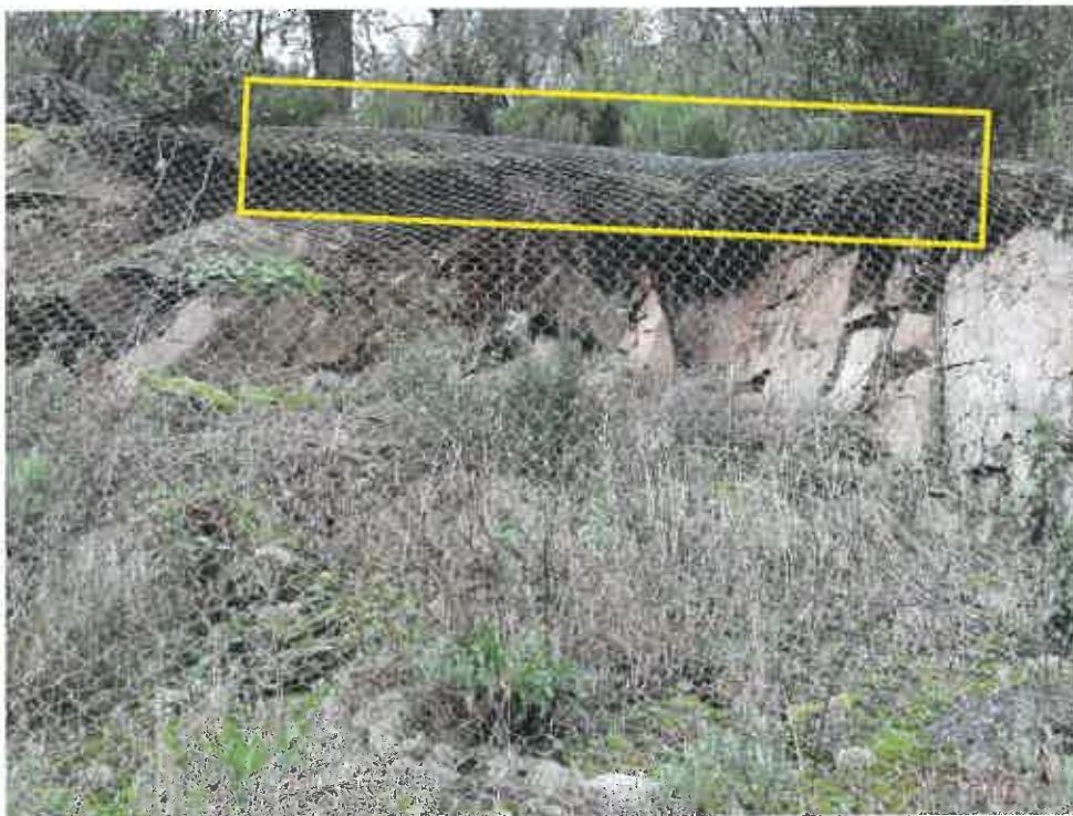
Fotografia 7 – Detalhe da formação de “consola” no topo do talude de escavação
