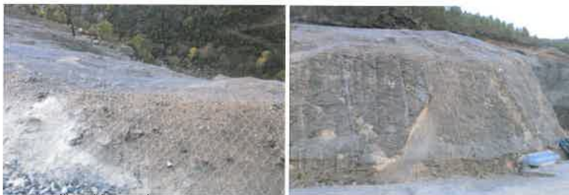
Figura 2 – Exemplo de aplicação de rede metálica de tripla torção: vista de topo (esquerda); rede metálica desenrolada ao longo do talude (direita)
