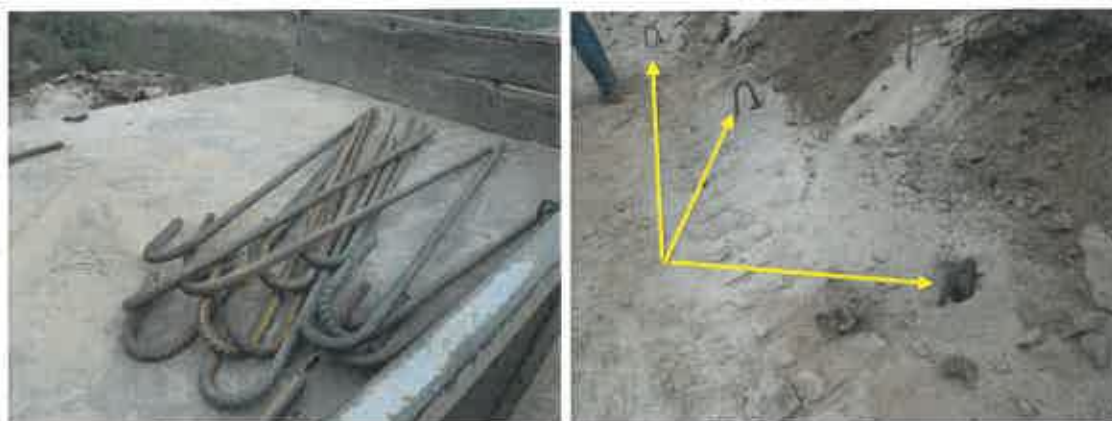
Figura 1 – Bengalas (varões de aço) de fixação da rede metálica ao talude
