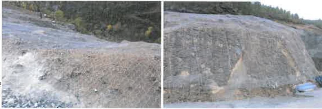
Figura 2 – Exemplo de aplicação de rede metálica de tripla torção: vista de topo (esquerda); rede metálica desenrolada ao longo do talude (direita)
