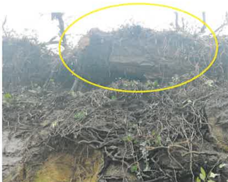
Fotografia 4 – Pormenor de bloco rochoso suspenso, no topo do talude de escavação, suportado por uma raiz de pinheiro
