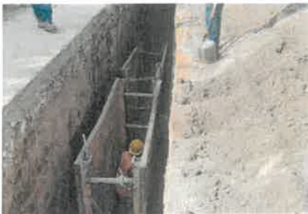
Foto 3 - Instalação de coletores de drenagem de águas residuais
