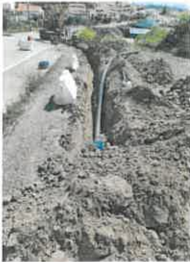
Foto 4 - Reabilitação de condutas de abastecimento de água
