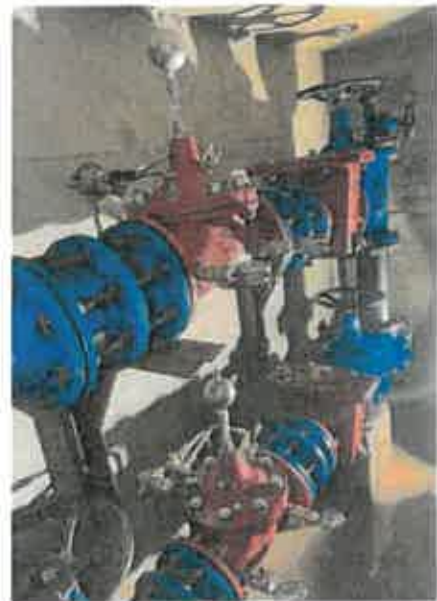
Foto 1 - Instalação de Válvulas Redutoras de Pressão
