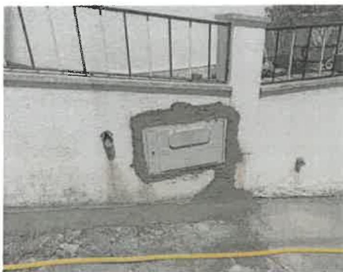
Foto 2 - Instalação de ramais de água
