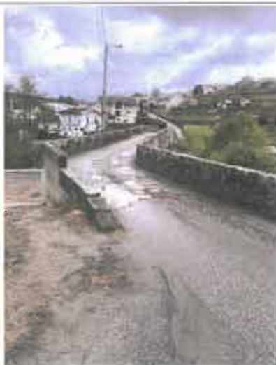
Figura 1 – Panorâmica da Ponte de Piscais
