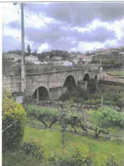
Figura 2 – Perspetiva jusante da Ponte de Piscais
