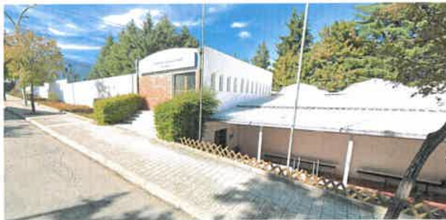
Figura 2 – Edifício das Piscinas Municipais Cobertas
