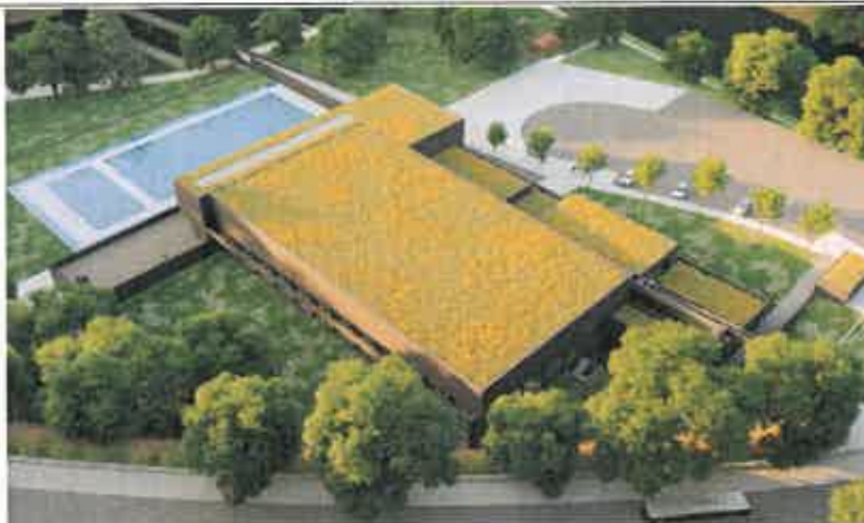
Figura 4 – Perspetiva da cobertura do edifício das piscinas interiores e exteriores
