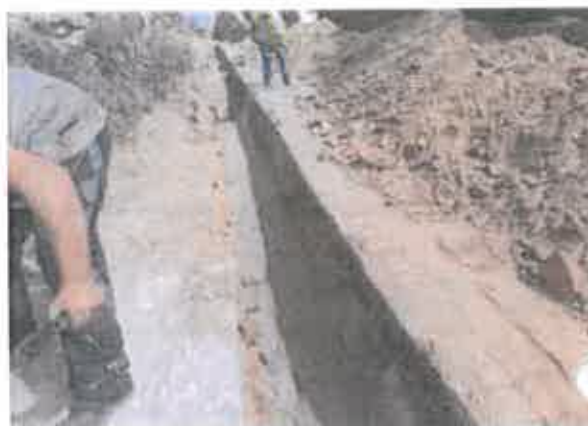
Figura 2 - FECHO DE SISTEMAS DE ÁGUAS RESIDUAIS EM VÁRIOS LUGARES DOS MUNICÍPIOS DE VILA REAL E SANTA MARTA DE PENAGUIÃO
