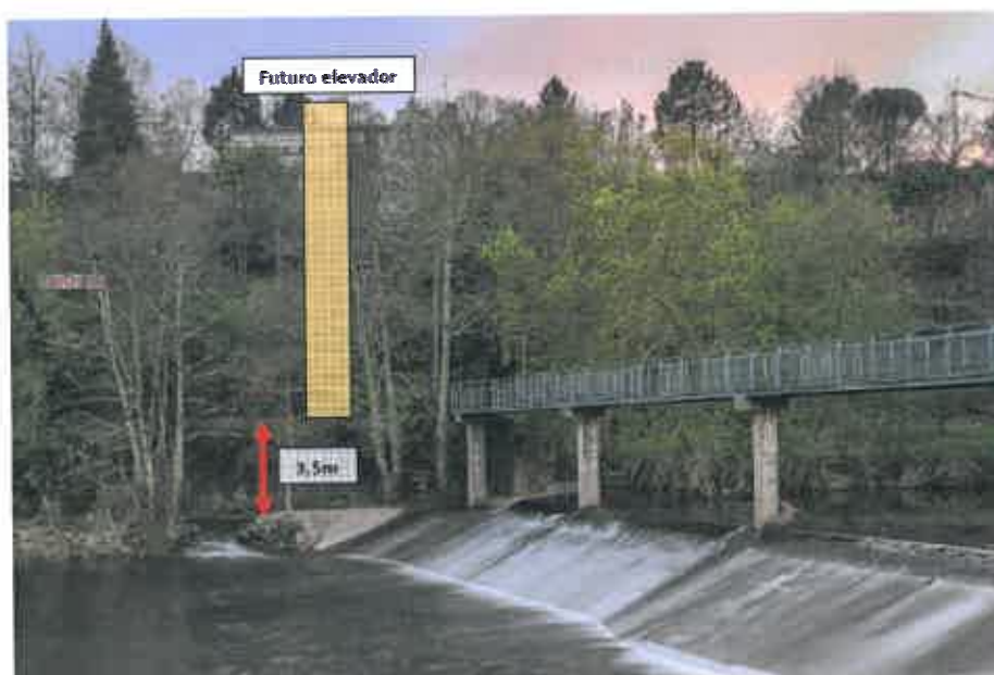
Figura 10 - Muro que suporta a plataforma (3,5m), limite da zona de cheia/inundável
