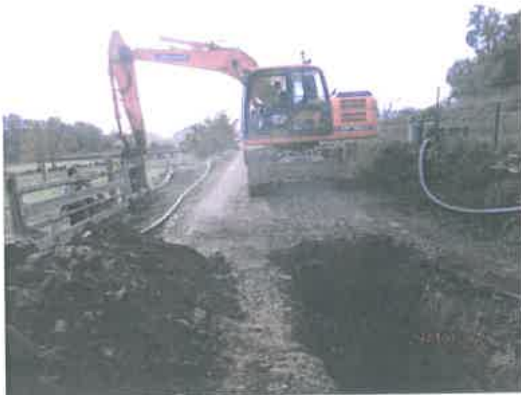
Foto 1 - Instalação de coletores
