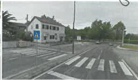
Solução inadequada (R. Santa Iria)
