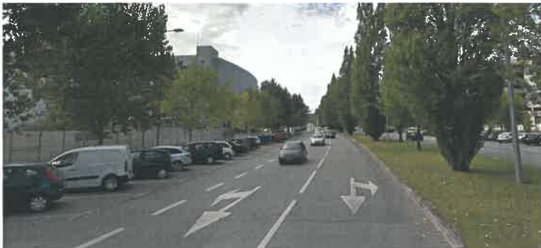
Figura 27 – Criação de faixas de largura adicional para apoiar a realização de manobras de estacionamento (local: Viseu)
