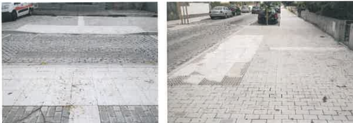
Imagem 2 e 3: Imagens tipo da implementação do pavimento tátil (direcional e de alerta) em dois arruamentos da cidade de Vila Real.
